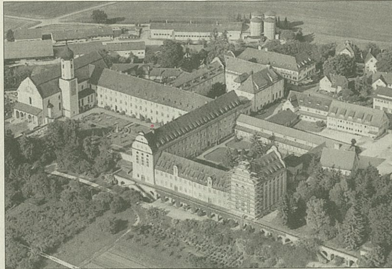
Einzelne Teile der Erzabtei Beuron sind sanierungsbedürftig.
